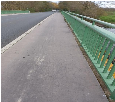
Photo N° 3 : bande cyclable sur le pont
