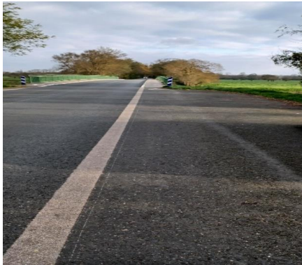
Photo N° 1 : vue d'accès au pont
