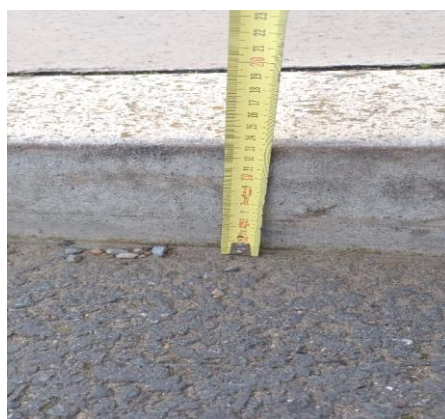
Photo N° 6 : Hauteur du trottoir
