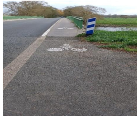
Photo N° 2 : accès au pont
