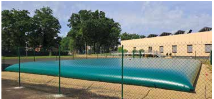
La citerne stocke une partie de l'eau des bassins.
