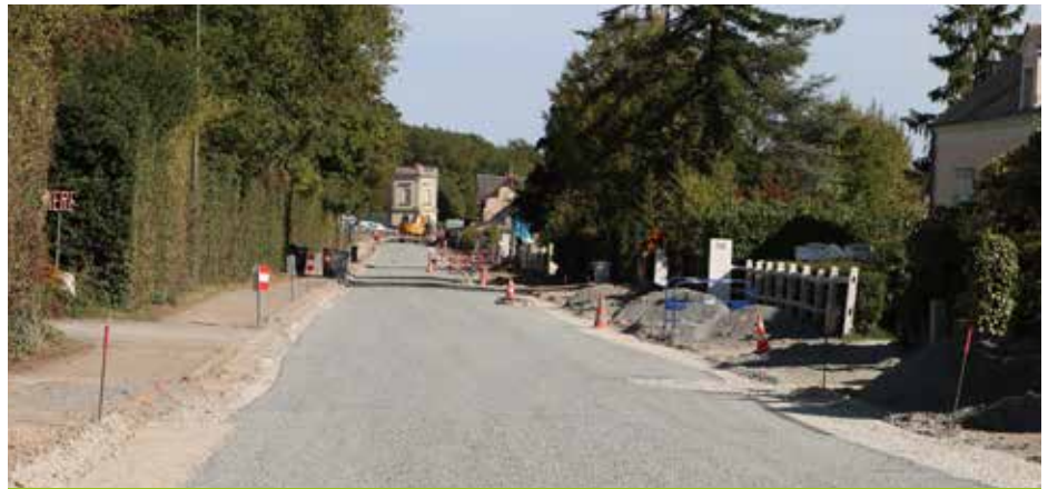
Les travaux de prolongement de la voie verte seront achevés mi-novembre.
