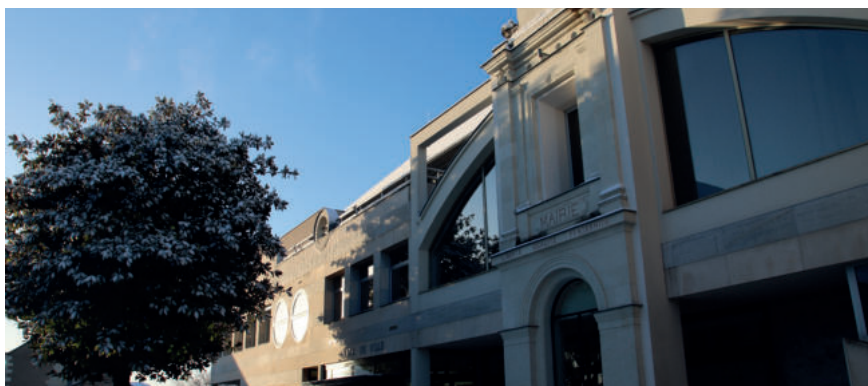
L'Hôtel de Ville fait partie des bâtiments équipés d'un système de GTB.
