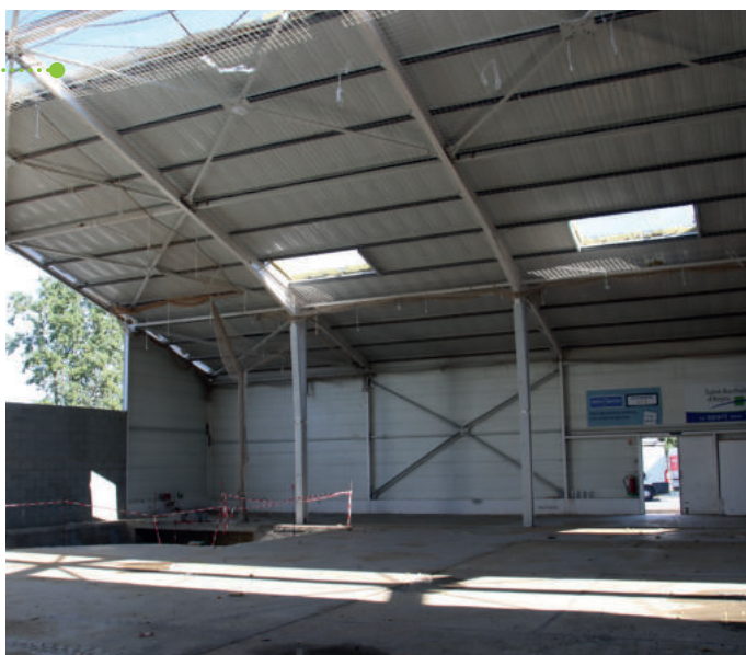
La phase deux des travaux concerne la salle de gymnastique.
